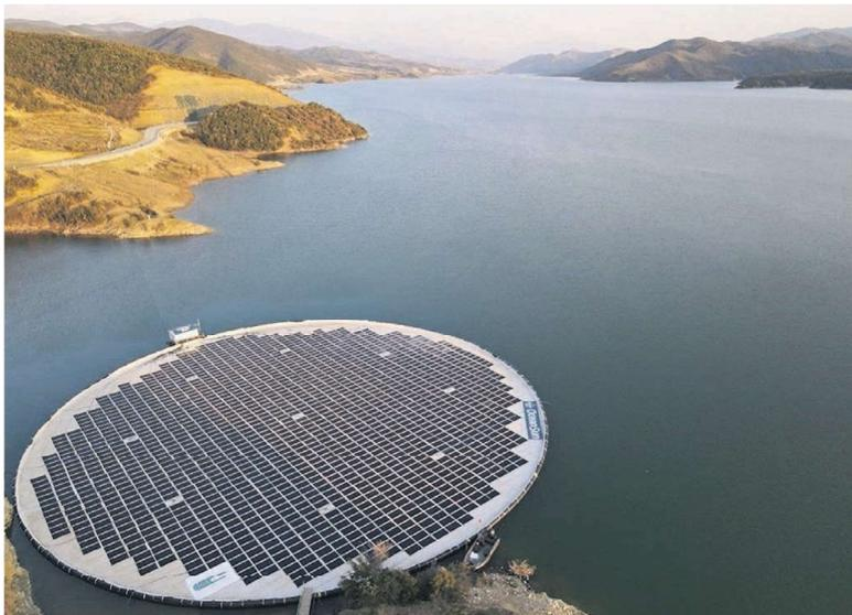
Das norwegische Unternehmen Ocean Sun AS stabilisiert durch Wasserkühlung die Effizienz von Solarmodulen, die bei hohen Temperaturen sinkt. Die Technologie wird auch zum Beispiel in der Energieerzeugung von Meerwasser-Entsalzungsanlagen eingesetzt. In Trinkwasserseen trägt das System dazu bei, dass das Wasser bei hohen Temperaturen nicht so stark verdunstet.
